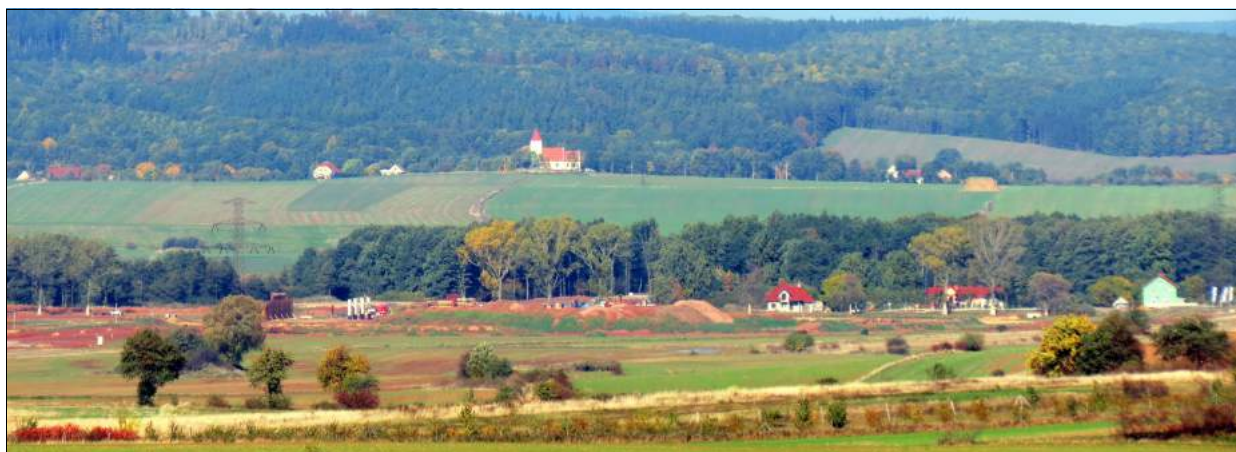
Ilustracja 119: Plac budowy węzła na S3 w Sadach Dolnych. Zdjęcie wykonano 29. 07. 2016 r. z wzniesienia za cmentarzem w Sadach Górnych, dalej widoczny Wolbromek. (fot. Cz. Z.).
