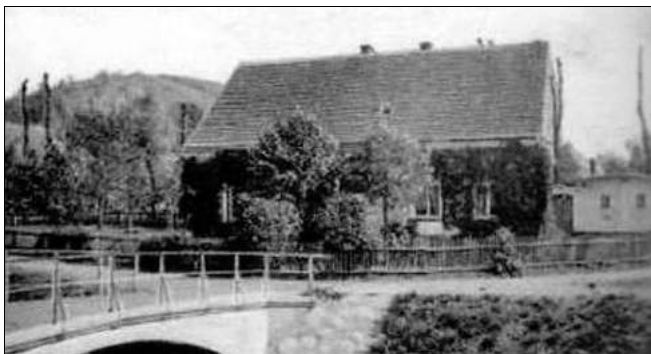
Ilustracja 32: Wierzchosławice Szkoła dolna , budynek nr 43, klasy 1-4 (tj. budynek naprzeciw kościoła.
