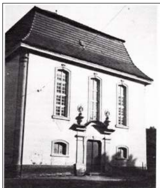
Ilustracja 19: Kościół murowany z 1783 r., główne wejście.
